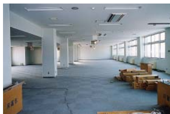
▲1991年 花川館 工事中
